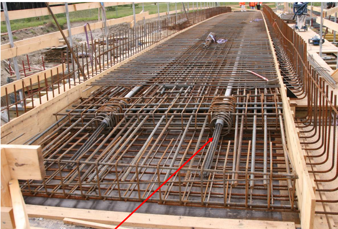
Armering med trækrør.
