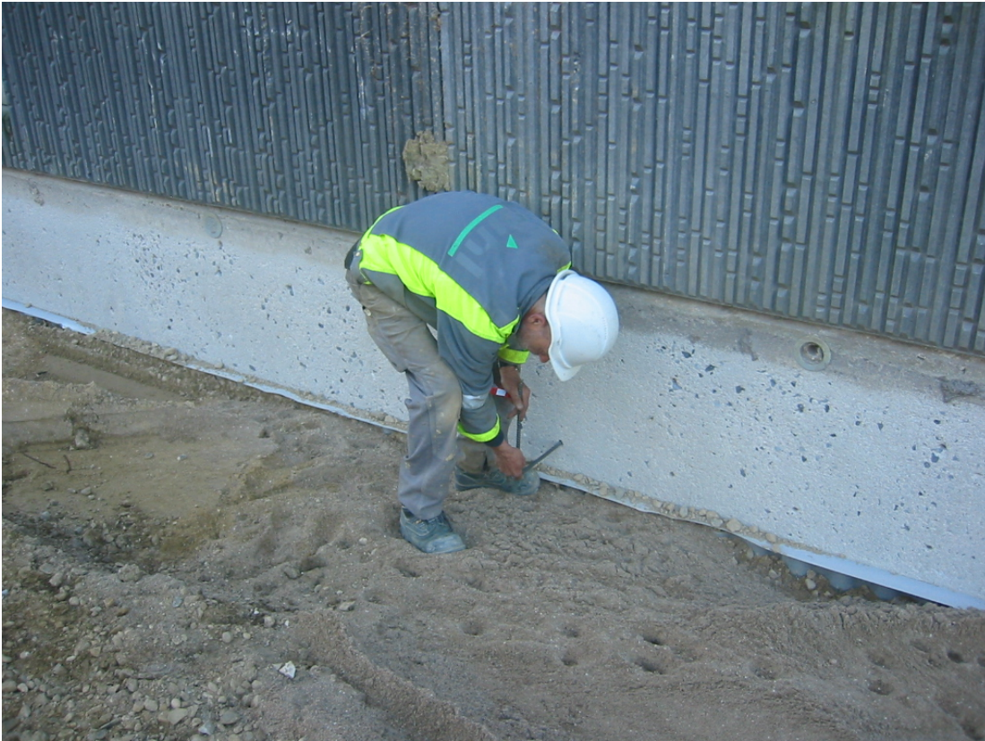
Isætning af stritter ved renovering.
