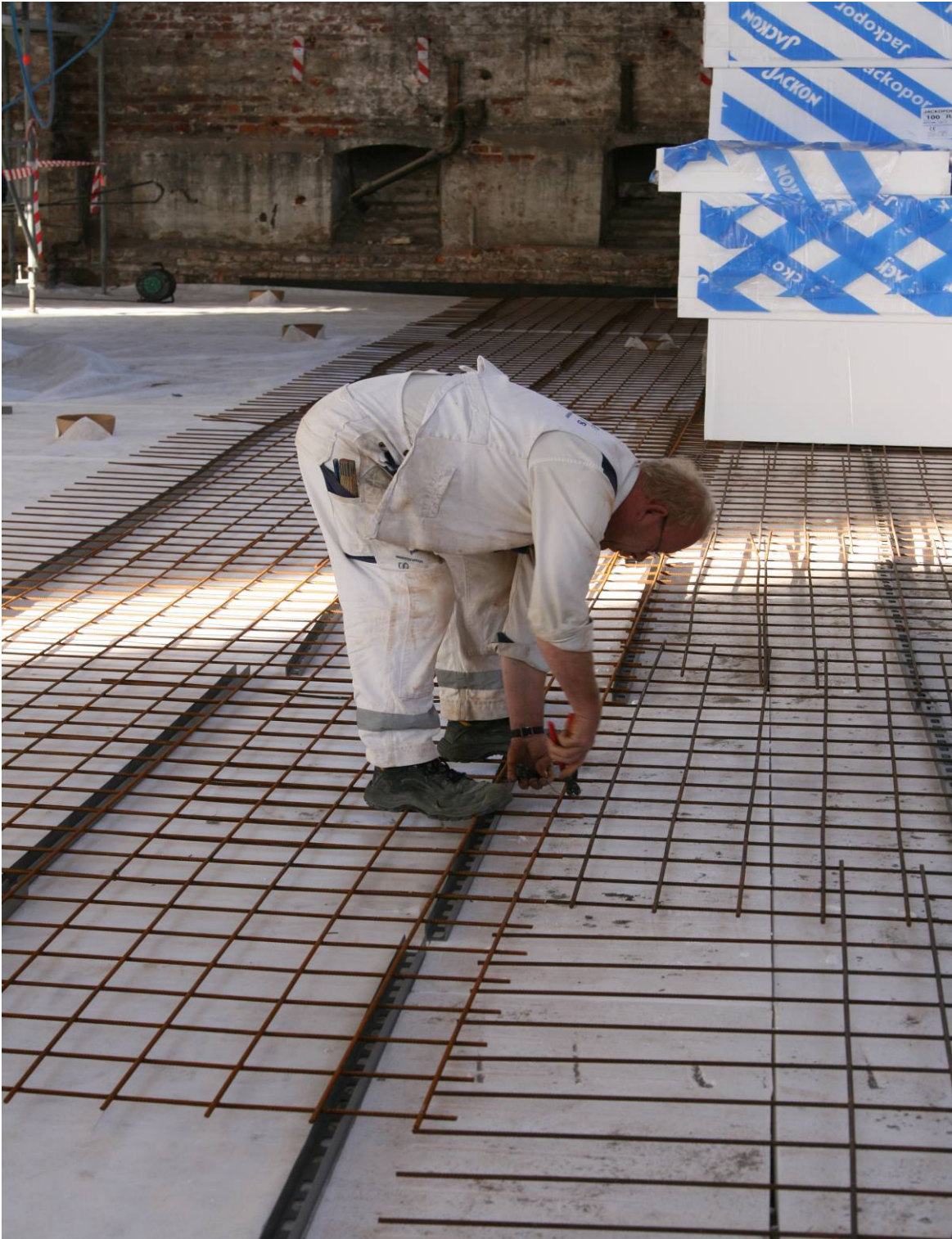
Jernbinding ved overlapninger i Rionet. Bemærk den dobbelt foroverbøjede stilling.
