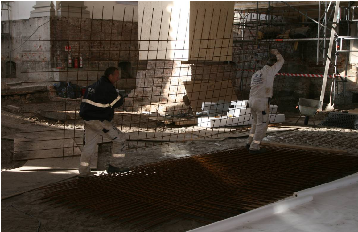
Rionet bæres til forbrugssted manuelt. Bemærk det ujævne underlag hvorpå det bæres.
