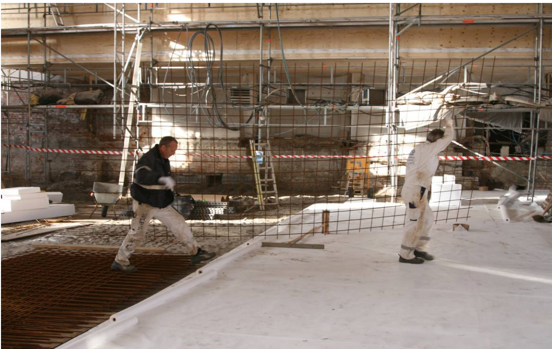
Manuel transport af Rio net ved renovering.
