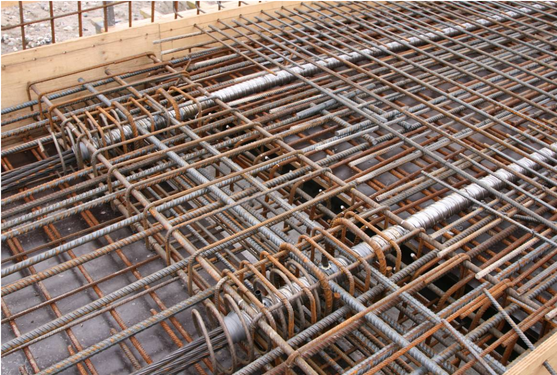
Tæt armering med store og små dimensioner armeringsjern.
