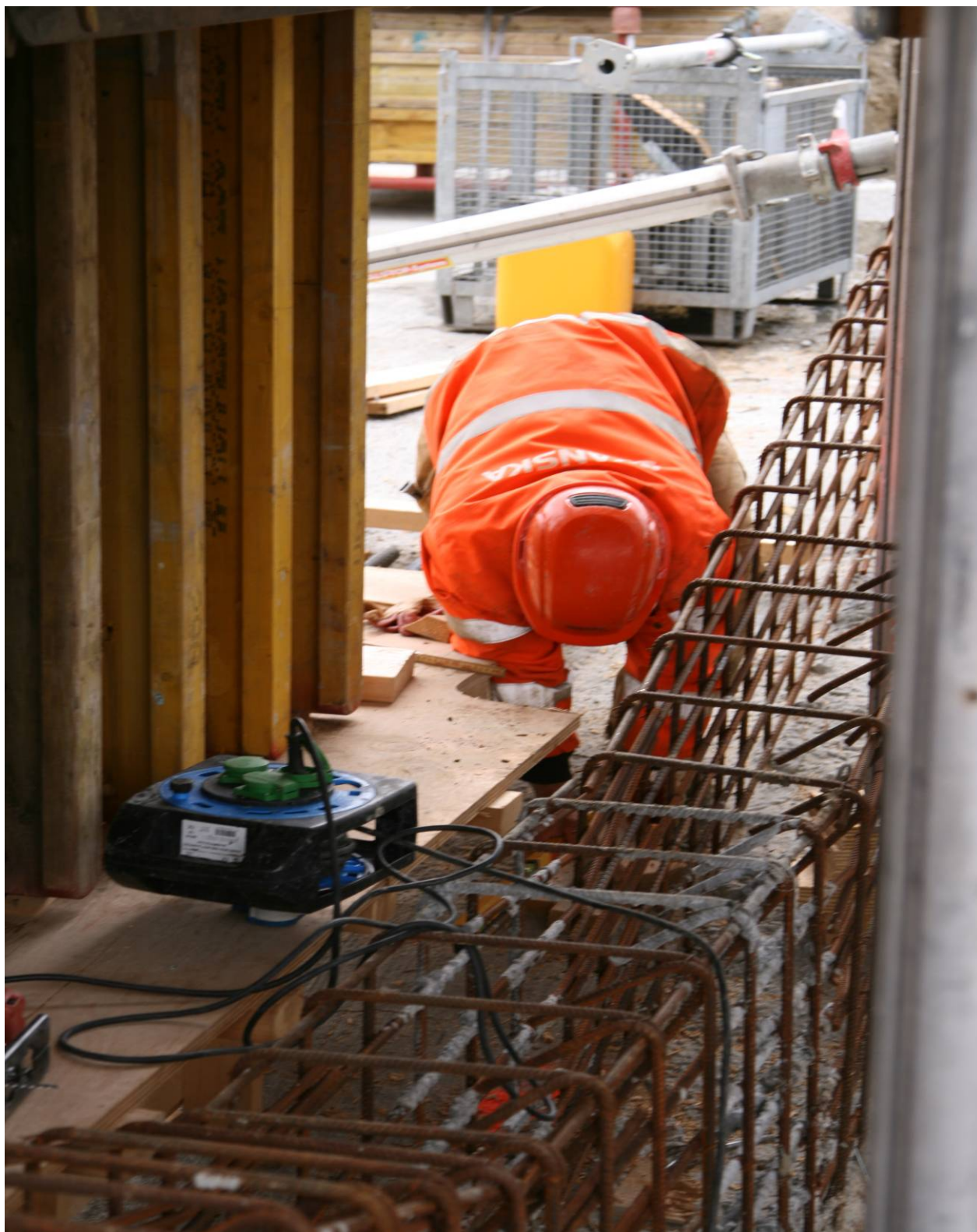
Akavet arbejdsstilling ved jernbinding.
