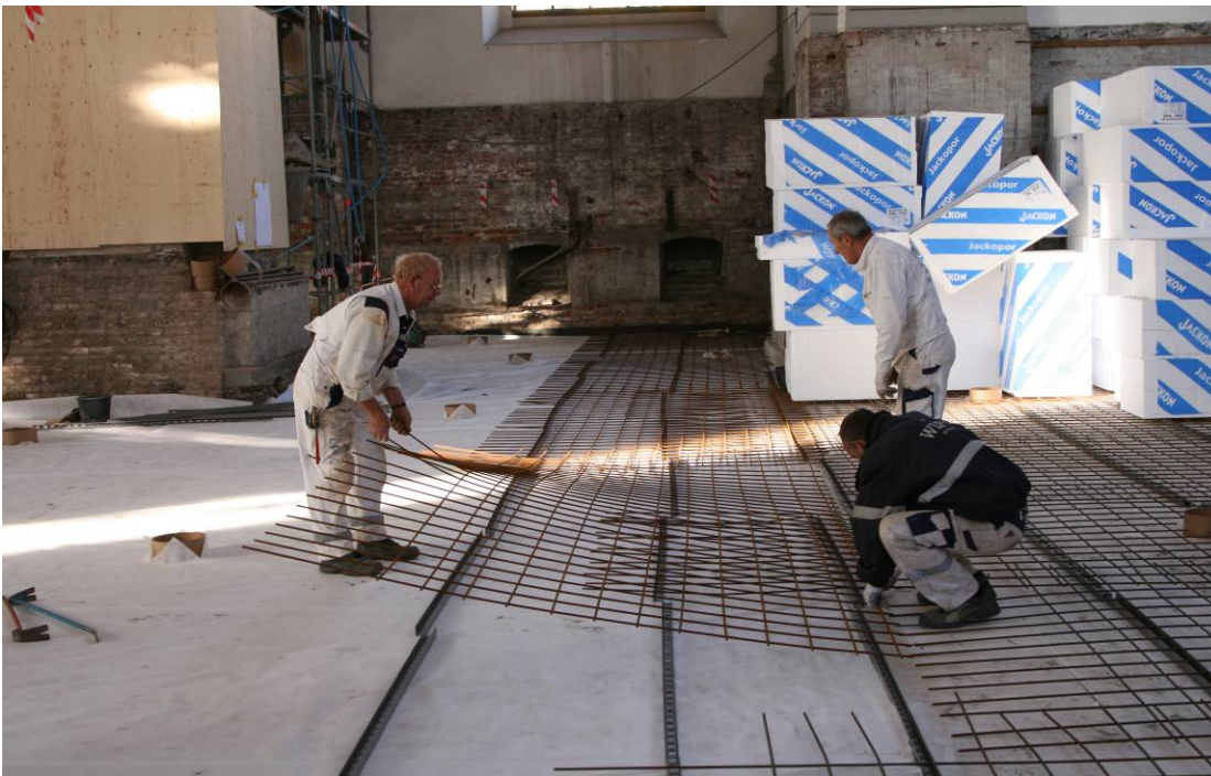
Rionet tilrettes på opklodsningsskinner.
