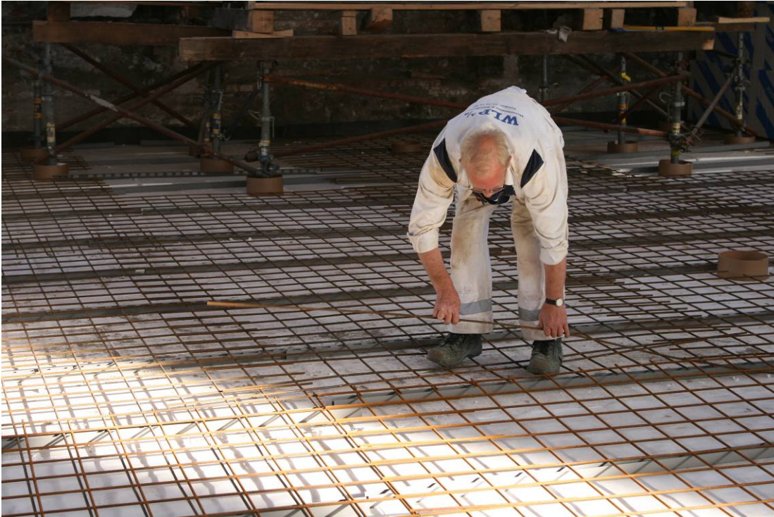
Stødjern monteres på Rionet. Bemærk den foroverbøjede stilling.
