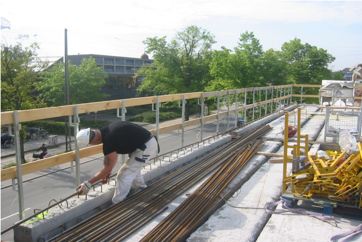
Ilægning af kantarmering. Jernet skubbes med håndkraft gennem indstøbte bøjler. 8 meter kraftigt stangjern.
